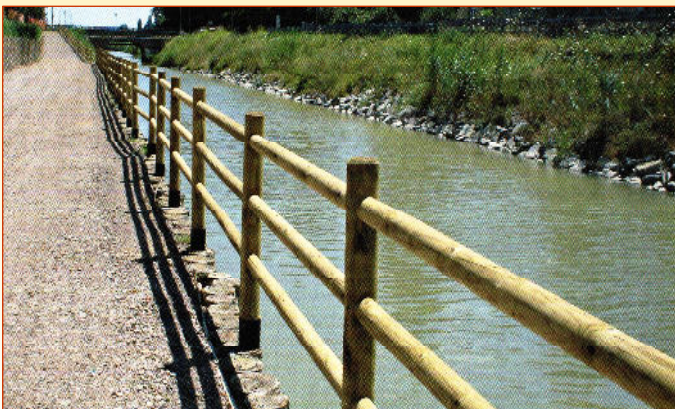
COD STLA STACCIONATA LAVARONE - LAVARONE FENCE
